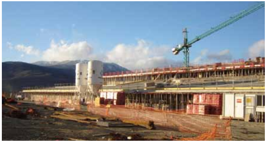
Hospital Transfronterer de la Cerdanya
