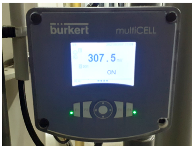
Control redox de la producción de ozono.
