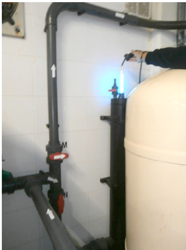
Làmpada UV dins del sistema de desinfecció de l'aigua.
