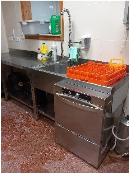
Imagen 1. Local de limpieza
