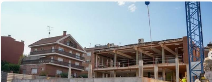
Obres Sant Fruitós de Bages Bages
