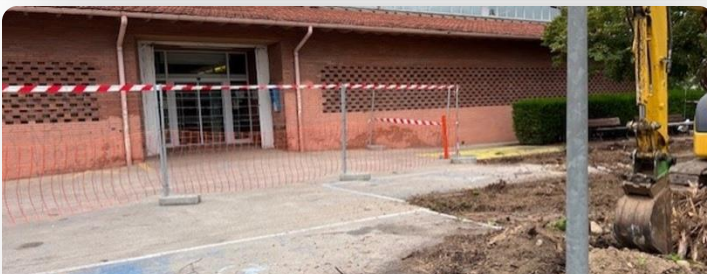
Comencen les obres d'ampliació del CAP Manlleu Manlleu
