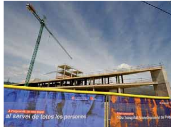
Construcció de l'hospital transfronterer a Puigcerdà
