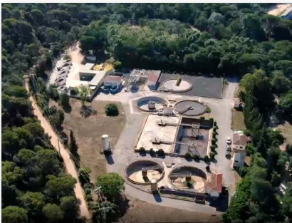
EDAR Tossa de Mar.
